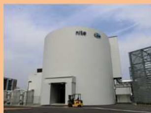
多目的大型実験棟
