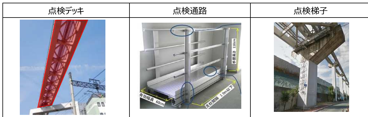
図 37：点検困難箇所の整備イメージ
