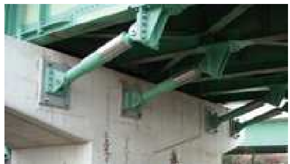
図 8-2 : 分岐橋制震装置のイメージ (粘性ダンパーの例)
