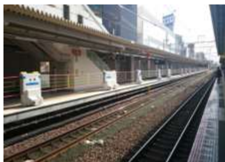
写真：昇降式ホーム柵の設置状況（JR高槻駅）
