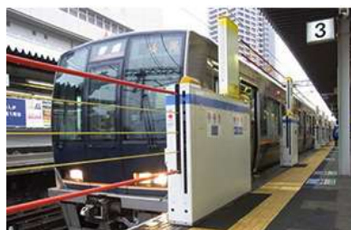
大阪駅 (高さ：約 1.3m、最大開口：約 13m)
