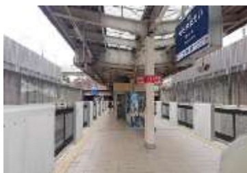
桃山台駅 (高さ：約 1.3m、最大開口：約 2.6m)
