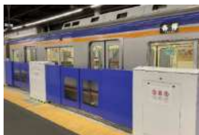
難波駅 (高さ：約 1.3m、最大開口：約 3.5m)
