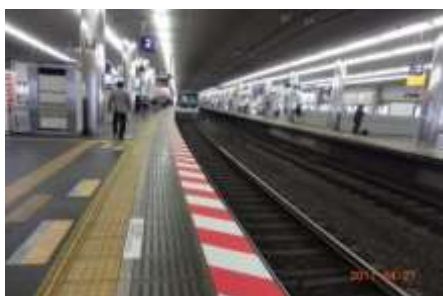
(ホーム端の注意喚起シート)
