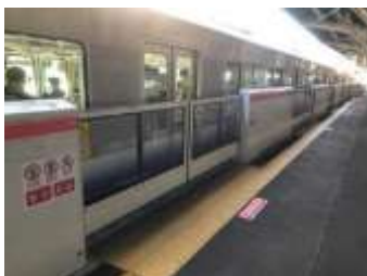
京橋駅 (高さ：約 1.3m、最大開口：約 3.5m)
