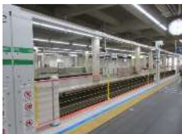
大阪阿部野橋駅 (高さ：約 1.3m、最大開口：約 13m)
