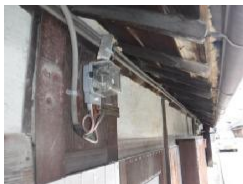
図 5.4 軒下配線 整備事例（富田林市寺内町）
