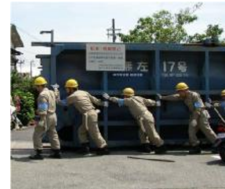
写真—防潮扉の閉鎖状況
