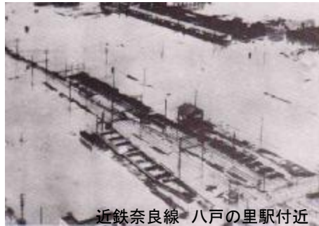
近鉄奈良線 八戸の里駅付近
