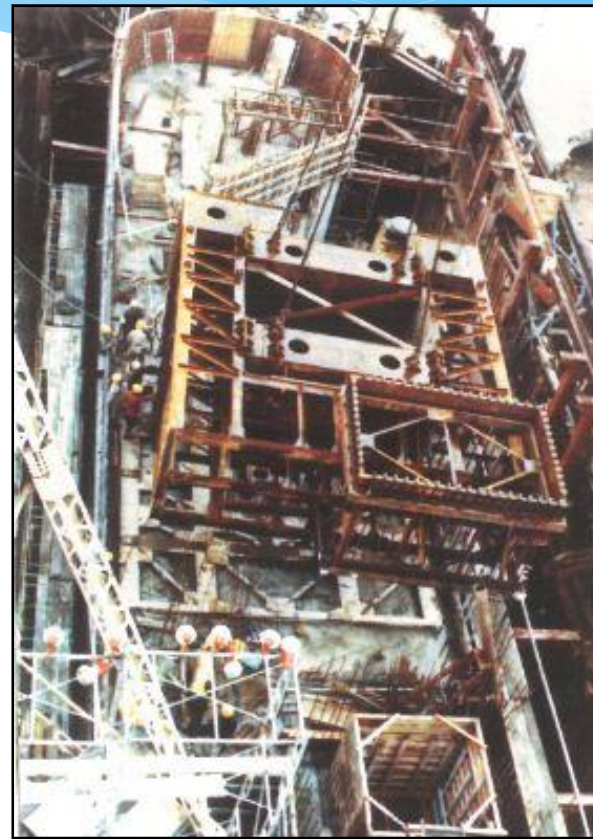
④アンカーレージ (堰柱に埋込)
