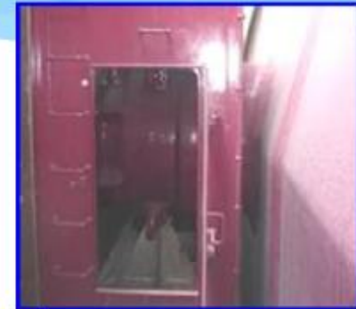
③回転支承部(ボス)
