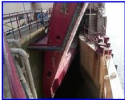
①扉体端部
