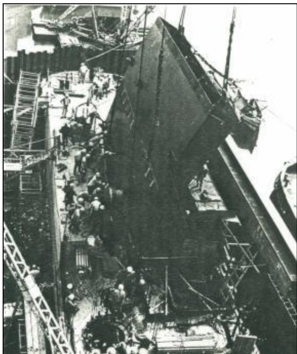
⑧扉体端部据付
