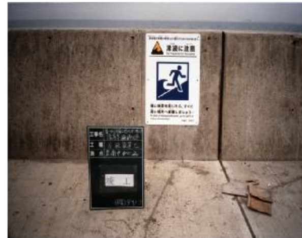
避難啓発看板の設置
