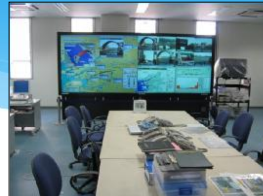
○ 津波・高潮ステーション〔防災棟〕
