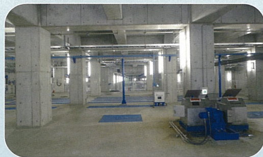
①水処理施設全景
