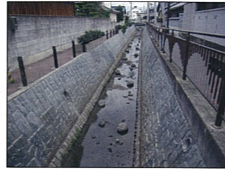
高度処理水を放流している寝屋川第十二水路
