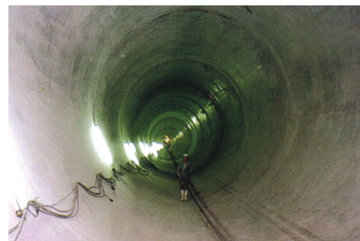
増補幹線の内部 増補幹線の内径は最大のもので6.25mもあります。
