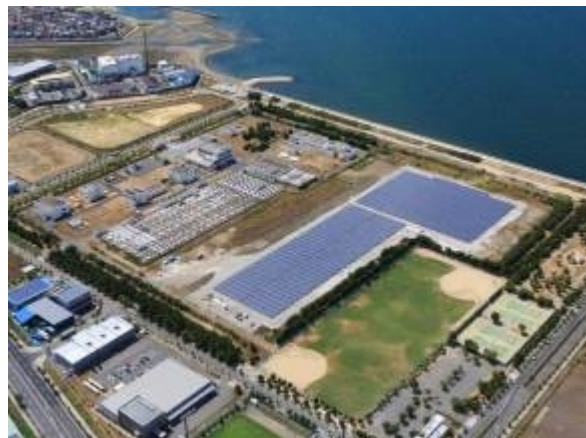
湾岸南部水みらいセンターメガソーラー
