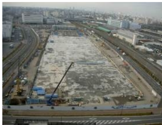
土木躯体完成
