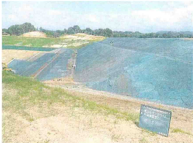
②8工区掘削のり面に植生吹付工が実施されております。特に湿った箇所なし
