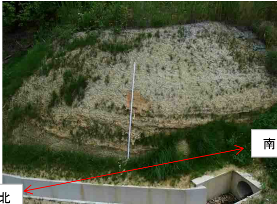
切取のり面の状況
