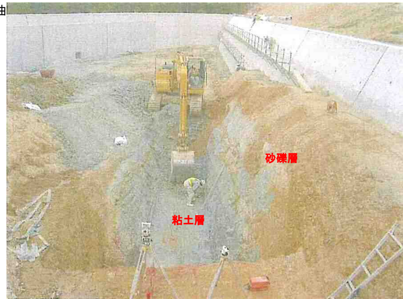
④ 8工区調整池底盤の施工状況、隔壁の床掘箇所に粘土が露頭、掘削直後は湧水なし。
