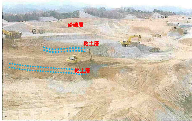
① 8工区の工事を北側から望む
