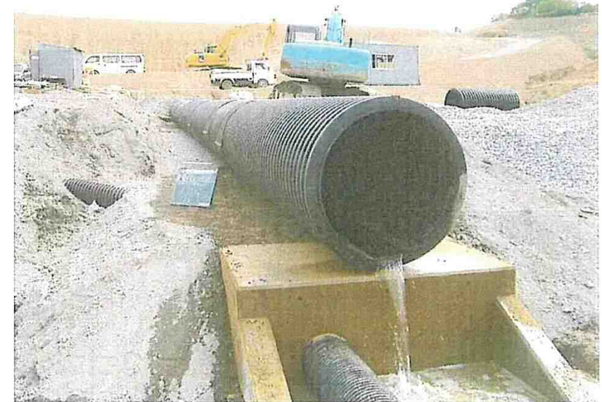
⑤流末の排水量(写真判読で約20リットル/min)
