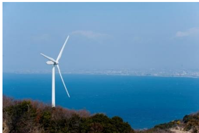
淡路風力発電所（関電エネルギーソリューション）
