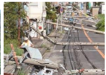
台風第21号による強風でたおれた電柱 (大阪府泉南市)
