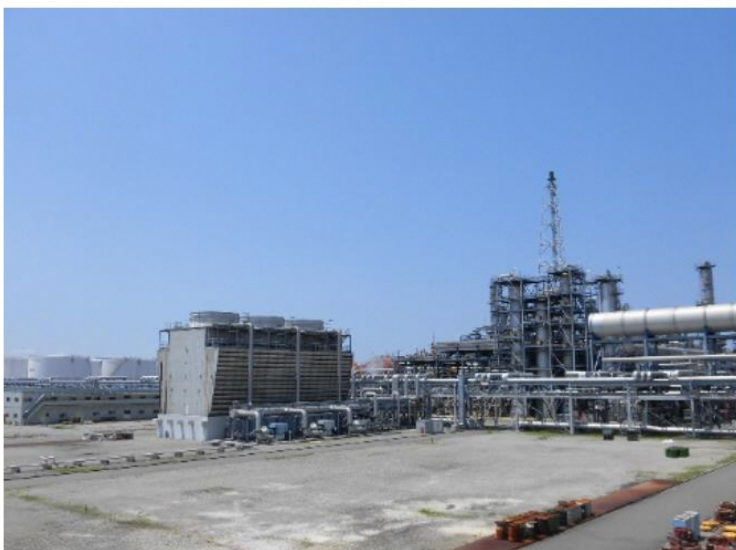
建設予定地写真
