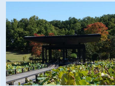
6号棟の塗装劣化
