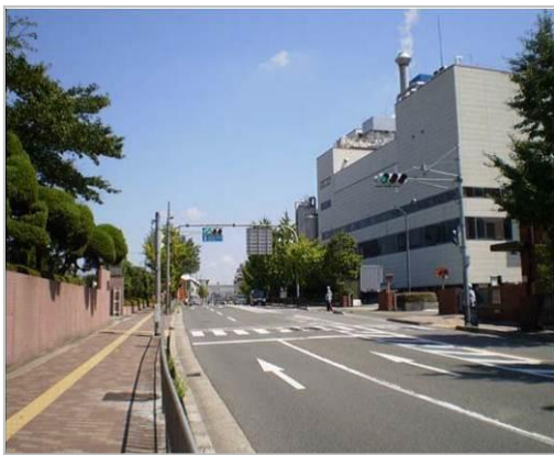
大阪高槻京都線（吹田市）
