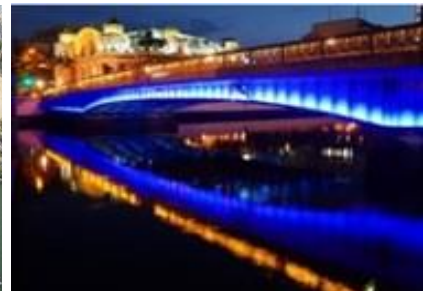
橋梁ライトアップ(鉾流橋) （大阪市北区）
