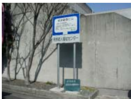
津波避難ビルとその標識 (静岡市資料)
