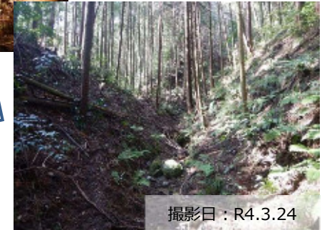
写真① 流木対策工の完了状況
