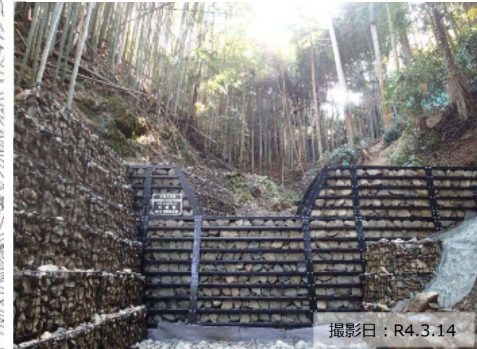
写真① 治山ダム（鋼製）の設置状況
