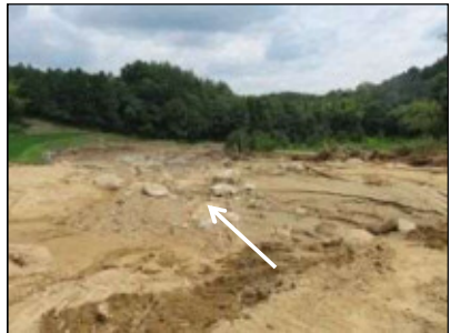
治山ダムがなく下流農地において 甚大な被害が発生(豊能町)
