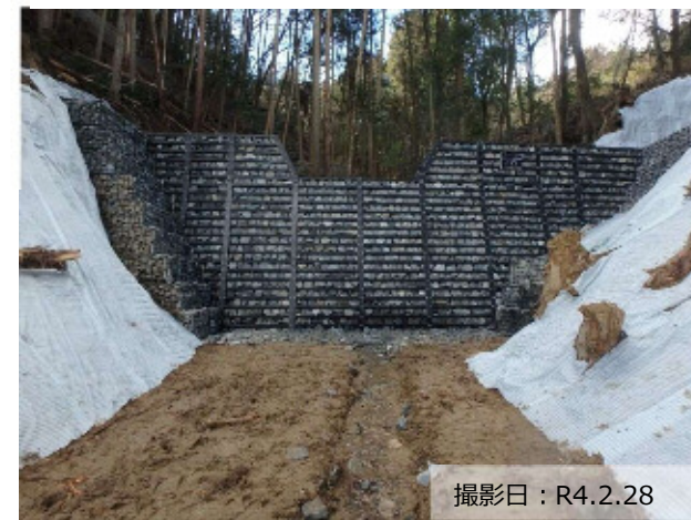
写真① 治山ダム（鋼製）の設置状況
