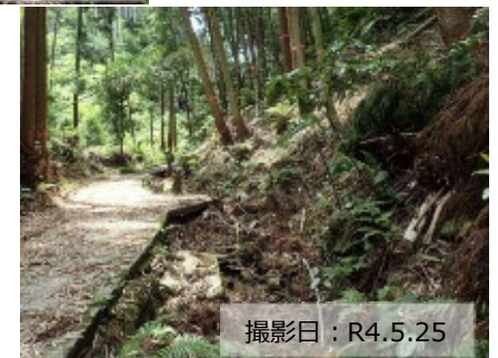
写真② 流木対策の完了状況 施工後
