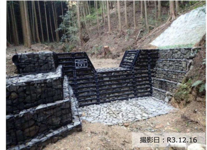
写真① 治山ダム（鋼製）の設置状況
