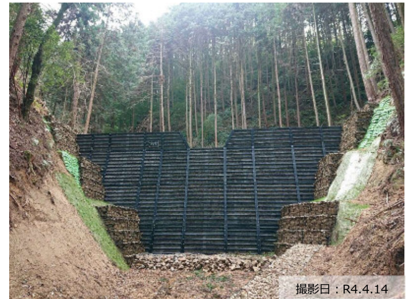
写真① 治山ダム（鋼製）の設置状況
