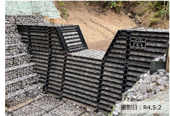
写真① 治山ダム (鋼製) の設置状況
