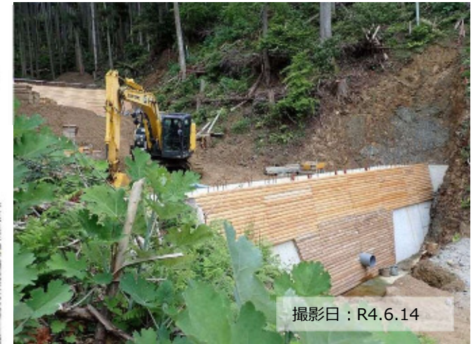
写真① 治山ダム（コンクリート）の設置状況
