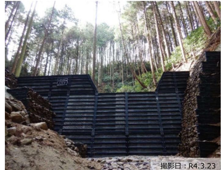
写真① 治山ダム（鋼製）の設置状況
