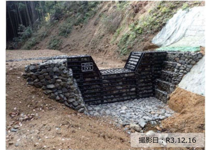
写真① 治山ダム（鋼製）の設置状況
