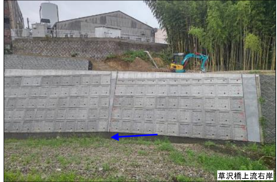
大型ブロックによる施工状況 【西除川（狭山池ダム上流区域）】
