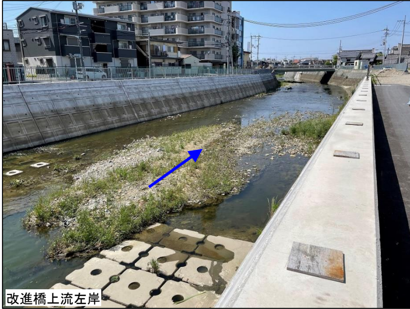
大型ブロックによる施工状況 【西除川（狭山池ダム下流区域）】
