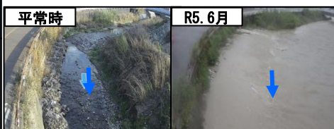
令和5年6月豪雨(飛鳥川:八丁橋上流)
