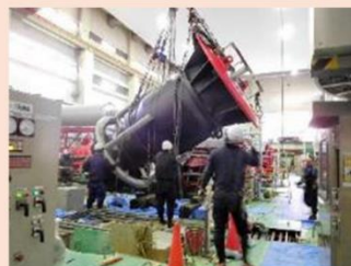
▲ポンプ設備の更新状況
