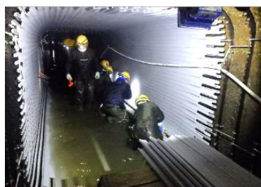
写真7 管渠の改築更新の例
