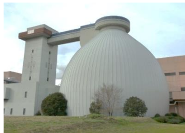
写真 19 消化槽(原田水みらいセンター)
