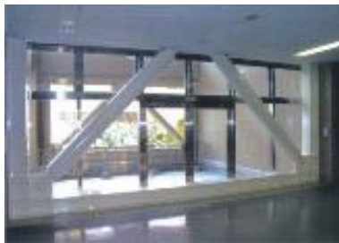
写真 16 建物の耐震化(補強材の設置)
