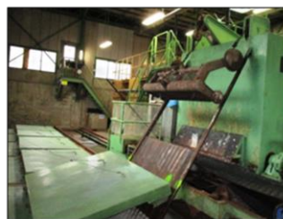
電気設備 操作盤
