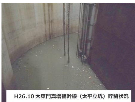
写真3 下水道増補幹線・地下河川における雨水貯留状況
