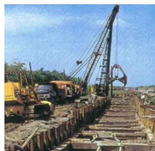
写真2 府道大阪中央環状線(当時建設中)での開削工事(昭和40年代)
