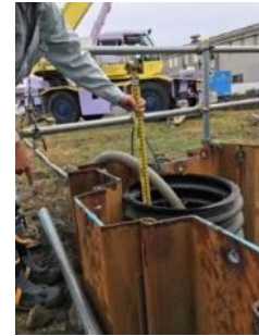
汚染土壌掘削工事の現地確認 状況(地下水位の確認)
