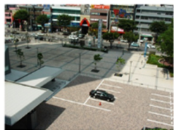
透水性・保水性舗装
