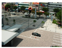
透水性・保水性舗装
