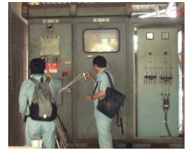
PCB廃棄物に係る立入検査
