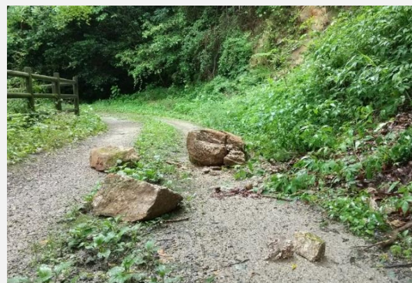
道路法面からの落石状況
