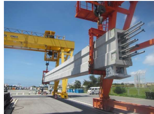
型枠を外した軌道桁
