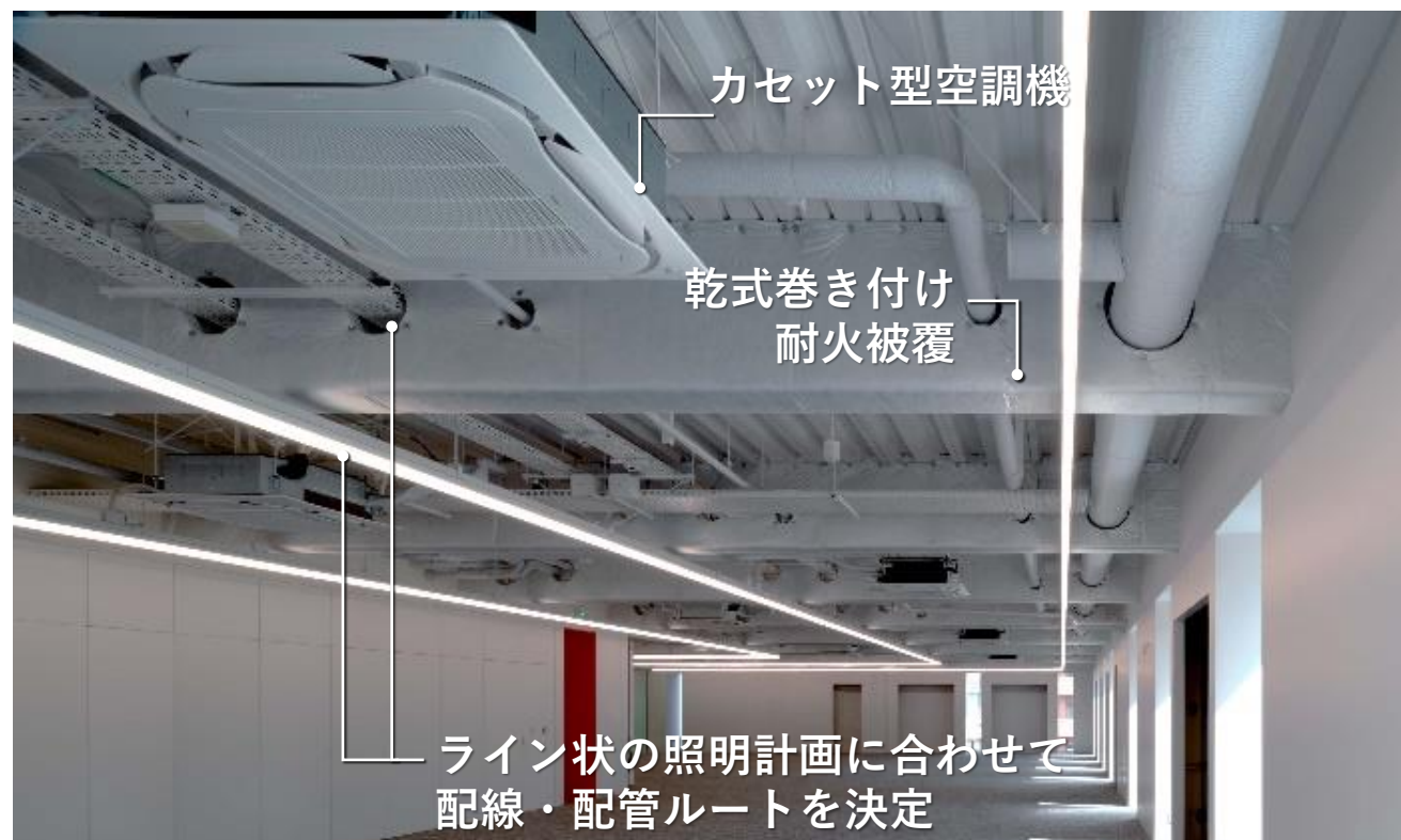
執務室エリア天井部
