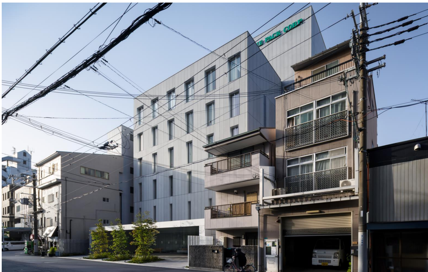
北側から建物を見る
