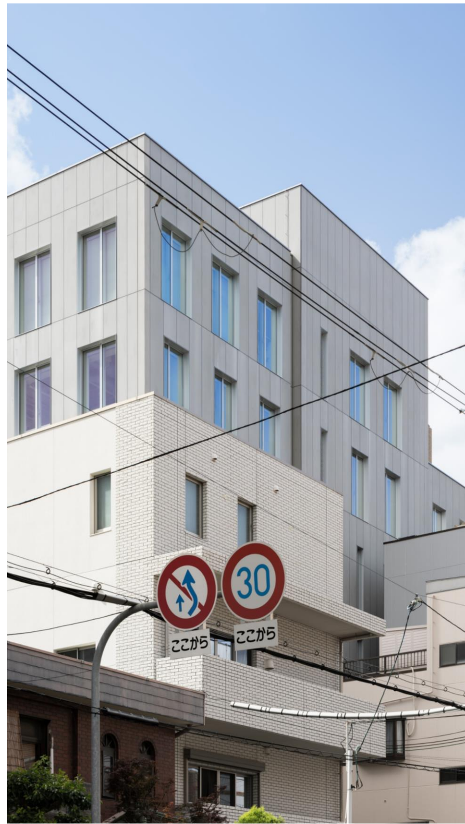
南東側から建物を見る
