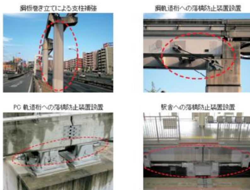
写真 1.1 大阪モノレールの耐震補強実施箇所
