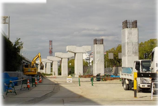
支柱建設工事
