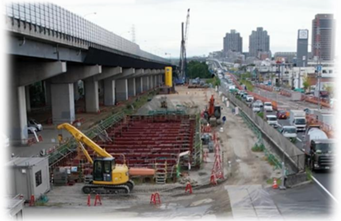
車両基地建設工事
