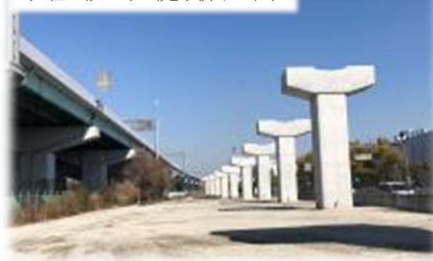
支柱建設工事 (完了済み工区)
