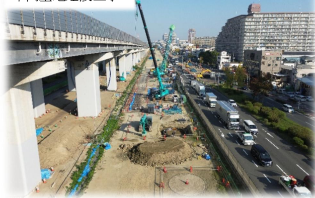
車両基地建設工事
