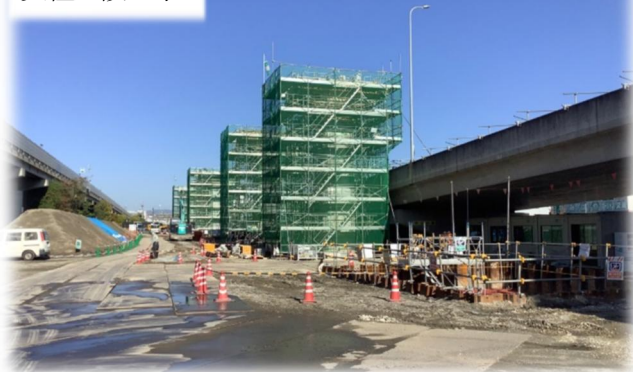
支柱建設工事
