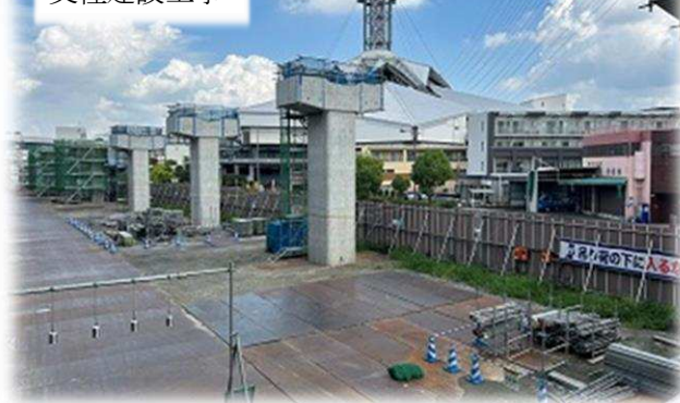
支柱建設工事
