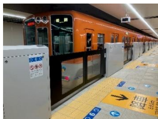
可動式ホーム柵の設置（扉式）
