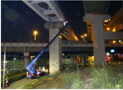
施設・設備点検の状況
