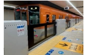
〔可動式ホーム柵の整備〕
