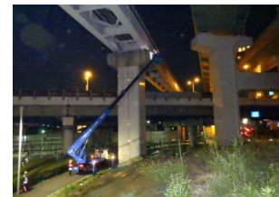
〔モノレール施設の点検〕
