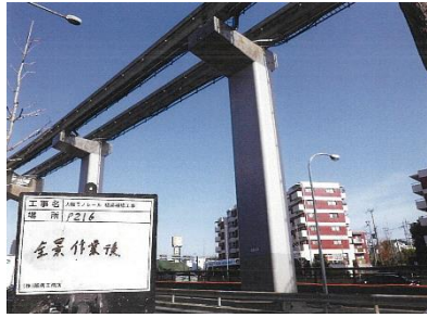
予防保全対策工事（塗装塗替）
