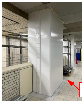
広域緊急交通路と交差する 開削トンネルの耐震補強
