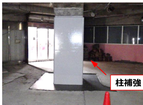
鉄道高架駅の耐震補強
