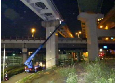
施設・設備点検の状況
