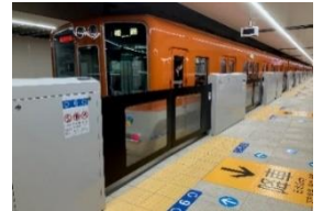
〔可動式ホーム柵の整備〕
