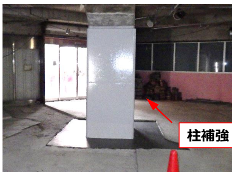
鉄道高架駅の耐震補強
