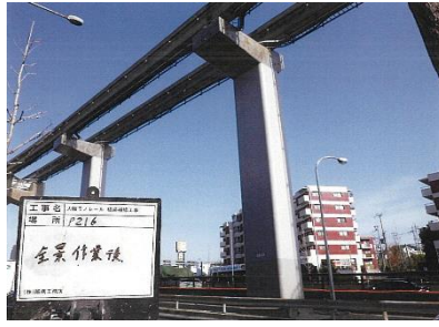
予防保全対策工事（塗装塗替）
