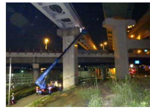
〔モノレール施設の点検〕
