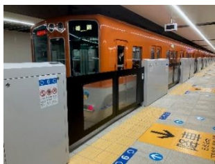
可動式ホーム柵の設置（扉式）
