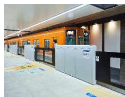
〔可動式ホーム柵の整備〕
