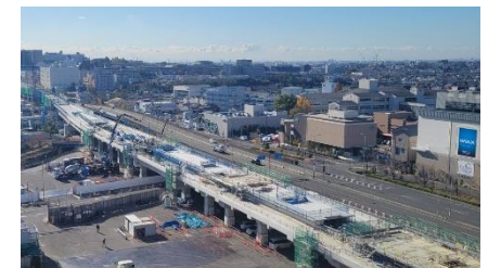
箕面萱野駅付近（高架橋工事）
