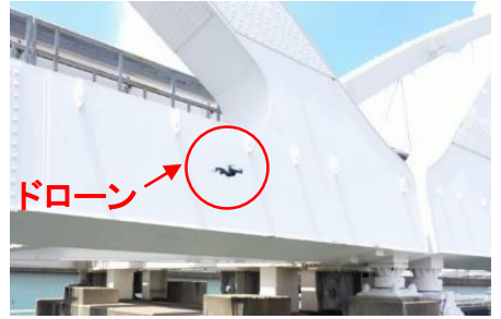
ドローンによる特殊橋点検
