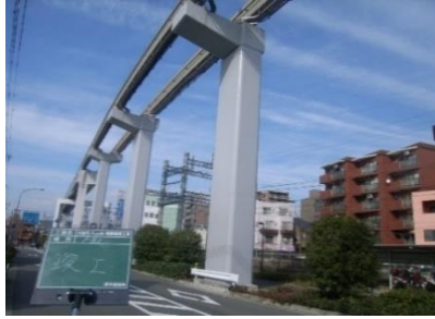
予防保全対策工事（塗装塗替）
