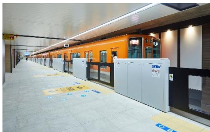
可動式ホーム柵の設置（扉式）
