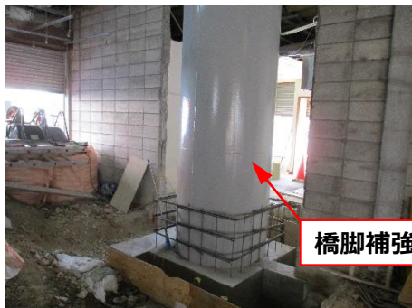
鉄道高架駅の耐震補強
