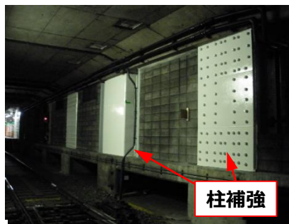
広域緊急交通路と交差する 開削トンネルの耐震補強
