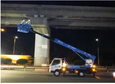
施設・設備点検の状況
