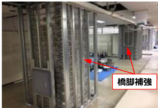
鉄道高架駅の耐震補強
