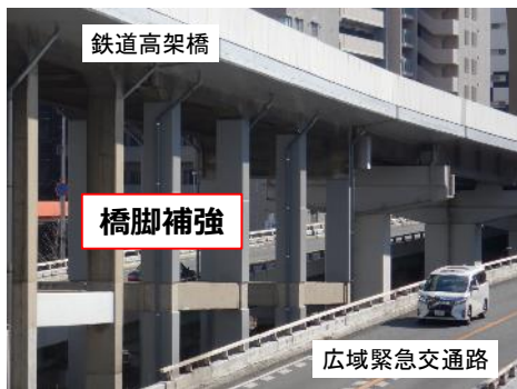
広域緊急交通路と並走する 鉄道高架橋の耐震補強
