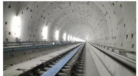
シールド区間 施工状況(軌道)
