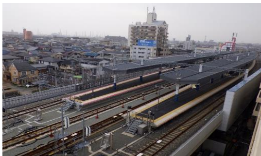
南海本線・高師浜線（高石市） 高架化工事の状況
