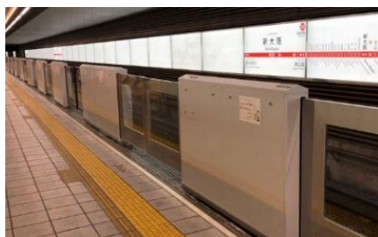
可動式ホーム柵の設置（扉式）
