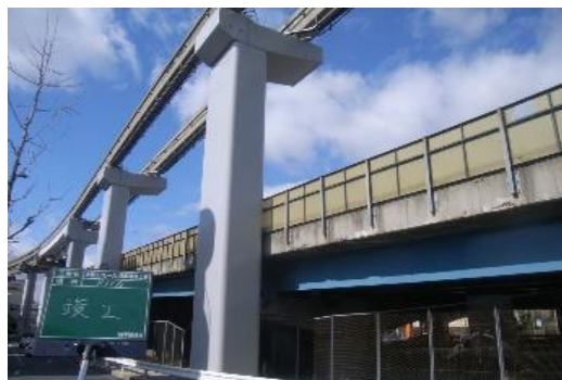
予防保全対策工事（塗装塗替）
