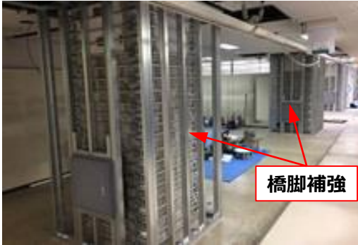
鉄道高架駅の耐震補強
