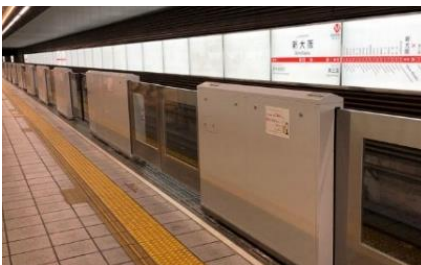
可動式ホーム柵の設置（扉式）
