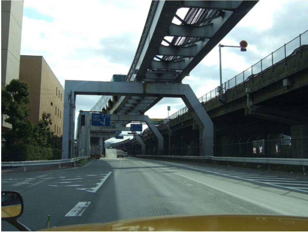
鋼軌道桁(沢良宜～摂津間)
