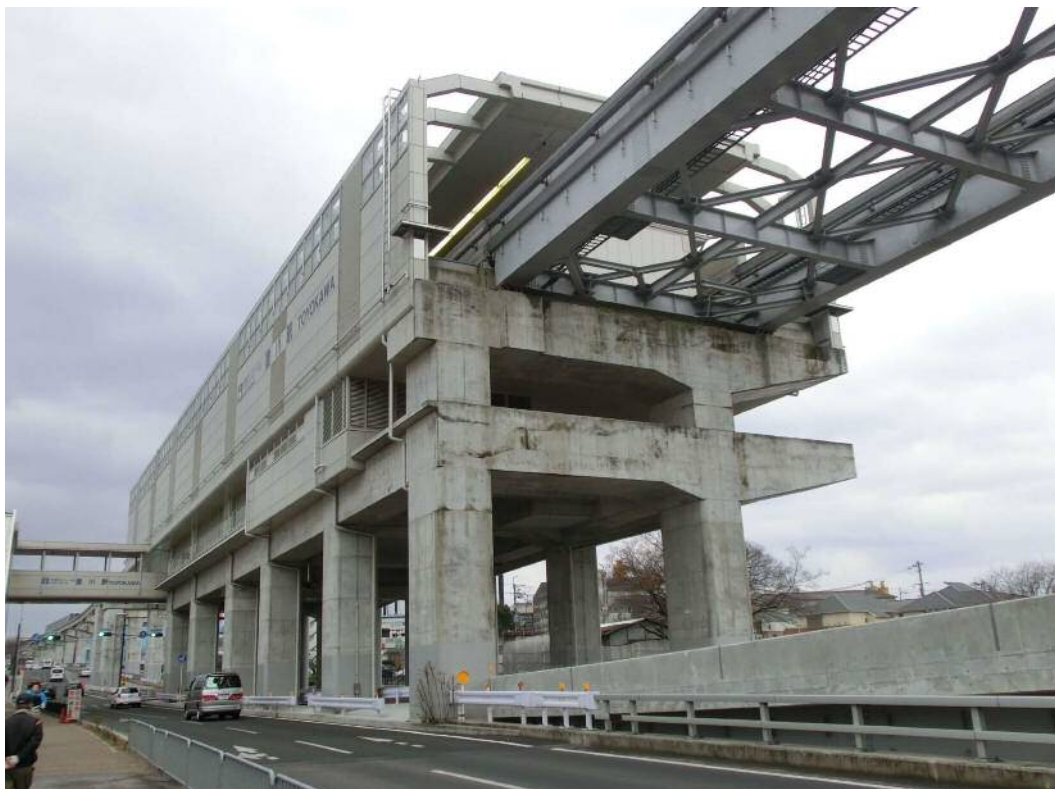
駅舎(RCラーメン構造)(豊川駅)
