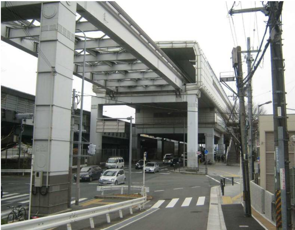
駅舎(鋼構造)(柴原駅)
