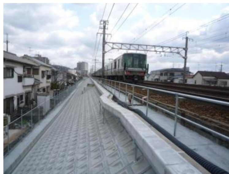
斜面防災対策
