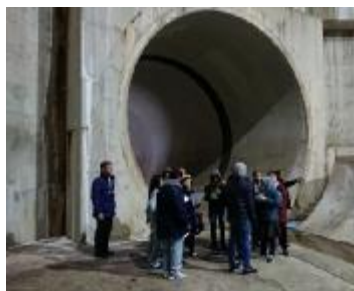
寝屋川南部地下河川
