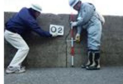
河川巡視点検の様子(H25)
