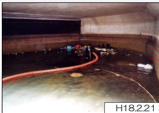
① 浚渫状況写真（新王子川）
