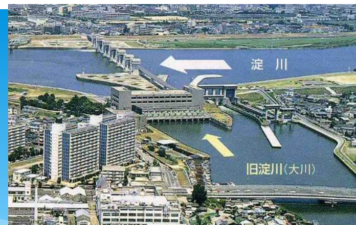
毛馬排水機場
