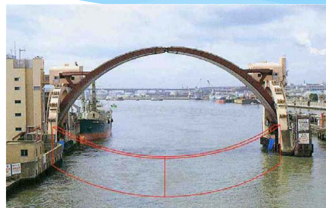
安治川水門(赤色は水門閉鎖時)
