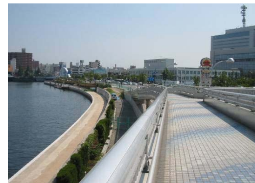
木津川・尻無川スーパー堤防区間
