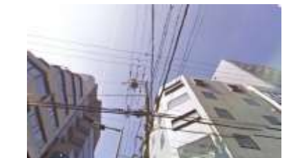
電線類の地中化
