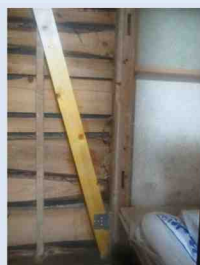
金物と筋かいの設置
