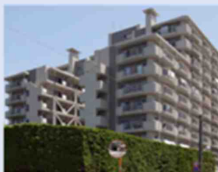
耐震改修済み
