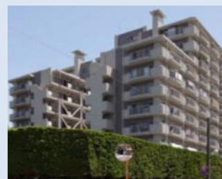
耐震改修済み
