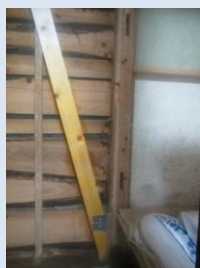
金物と筋かいの設置
