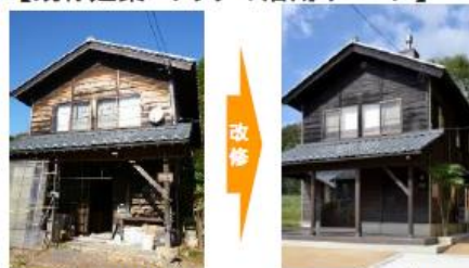
改修前(空き家)
