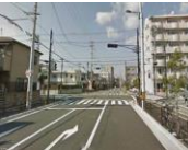
広幅員道路整備
