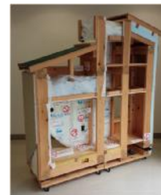
断熱施工模型
