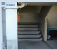
(共用廊下等への手摺設置例)
