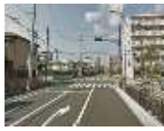
広幅員道路整備
