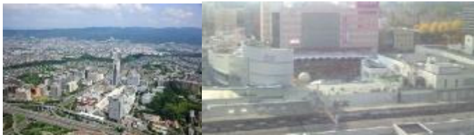
地区センターの活性化（千里中央・千里北地区センター）
