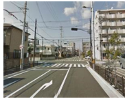
広幅員道路整備
